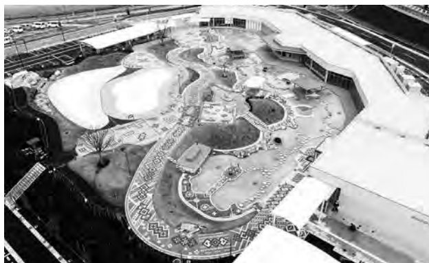
施工に携わった施設
