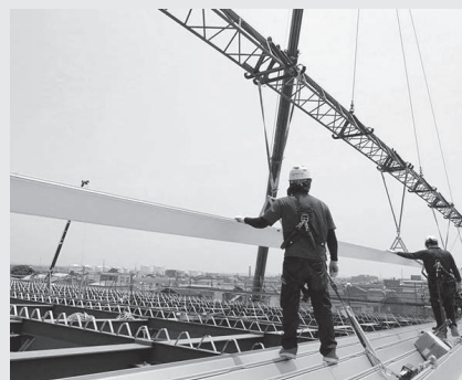
作業現場の様子
