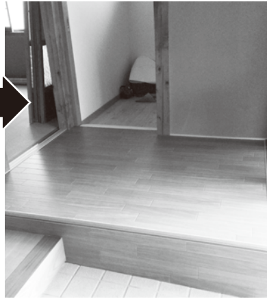
車いす利用のため、居室からトイレの段差に玄関のスペースを利用して踊り場を設置した住宅改修事例
