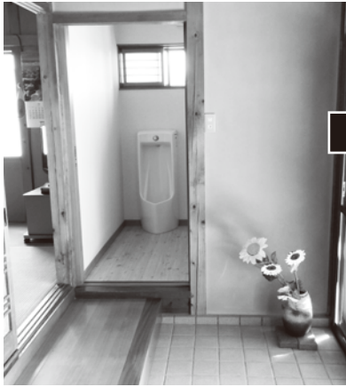
車いす利用のため、居室からトイレの段差に玄関のスペースを利用して踊り場を設置した住宅改修事例
